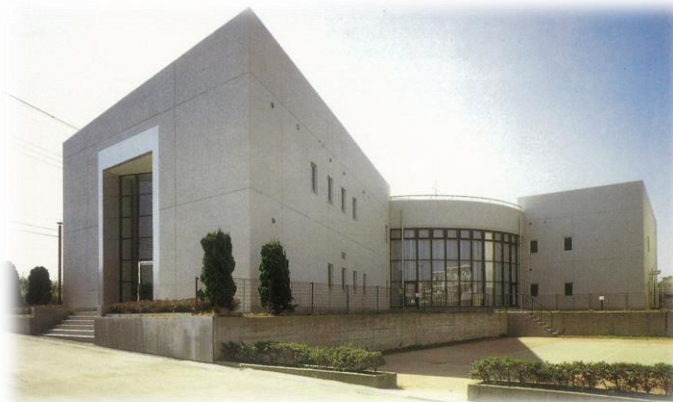
現校舎（昭和60年3月竣工）
