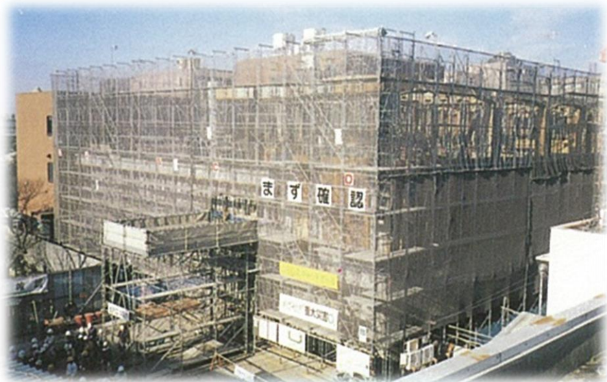
建設中の 新病棟（東館）
