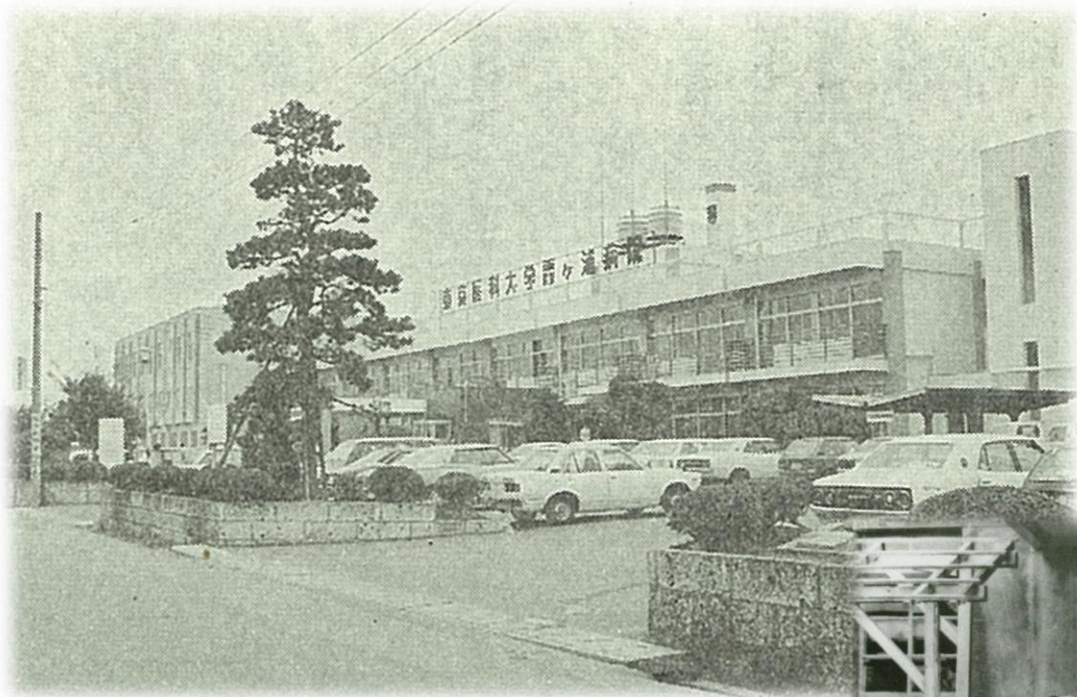
外来診療棟竣工(昭和43年3月)
